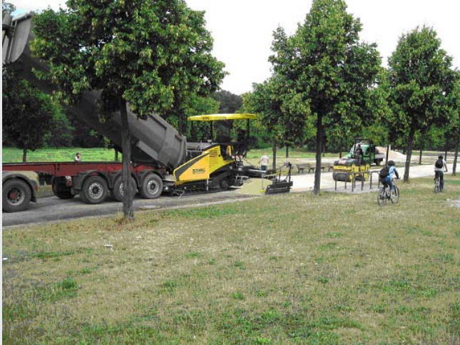
Der Wegebaustoff wird in den Fertiger geschüttet.
