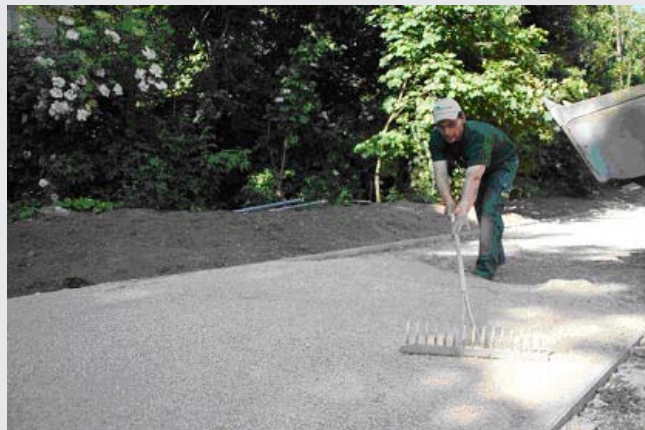
Verteilen der Deckschicht Gelsenrot gelb beige 0-8mm
