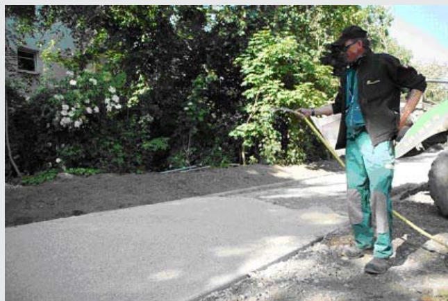
Material durchdringend wässern
