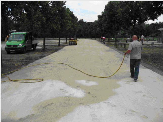
Die Wegedecke wird angefeuchtet und anschließend ange- walzt.
