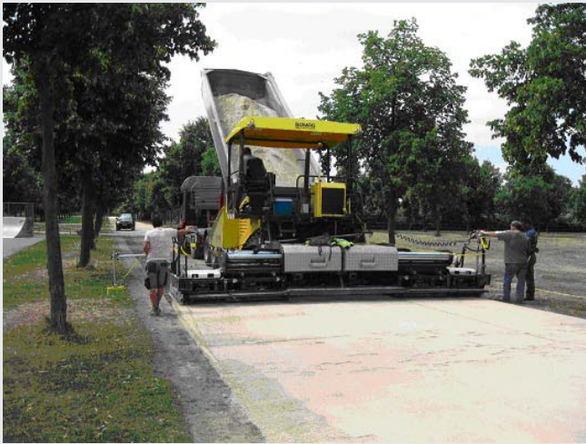
Der Wegebaustoff wird mit dem Fertiger verteilt.
