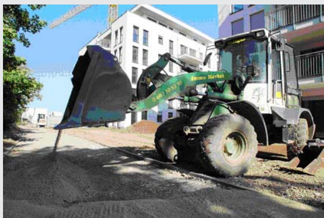
Ausbringen der Deckschicht Gelsenrot gelb beige 0-8mm
