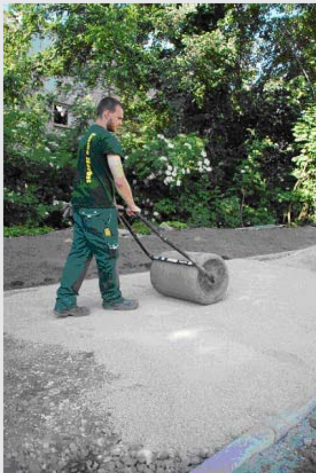
Deckschicht statisch verdichten
